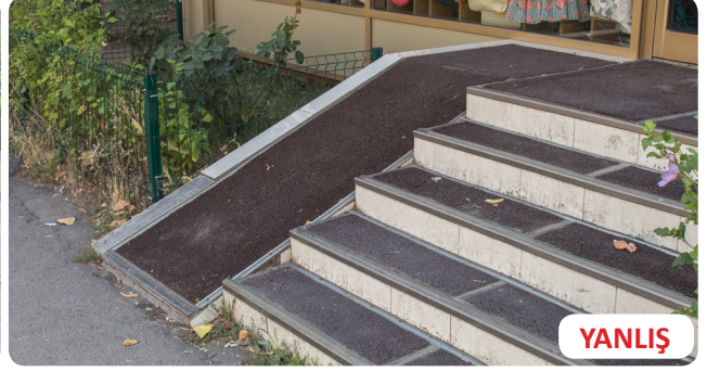
Görsel 6.24: Doğru eğimli rampa ve yanlış eğimli rampa
