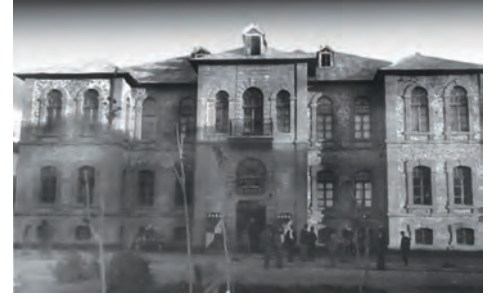
Görsel 3.2: 15. Kolordu Komutanlığı Binası, Erzurum, 1920
