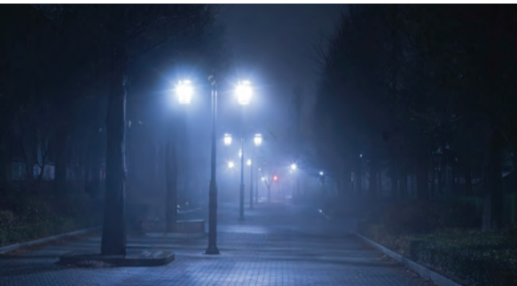
Görsel 5.20 Uygun olmayan sokak aydınlatması
